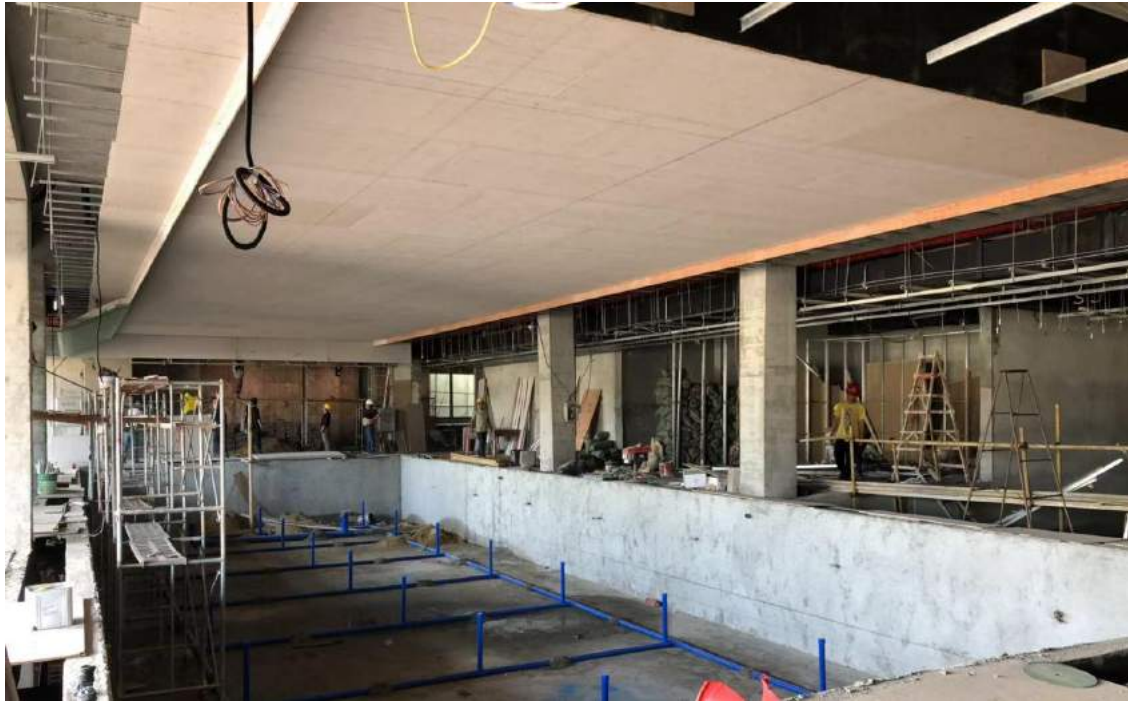
管道和过滤系统的安装
